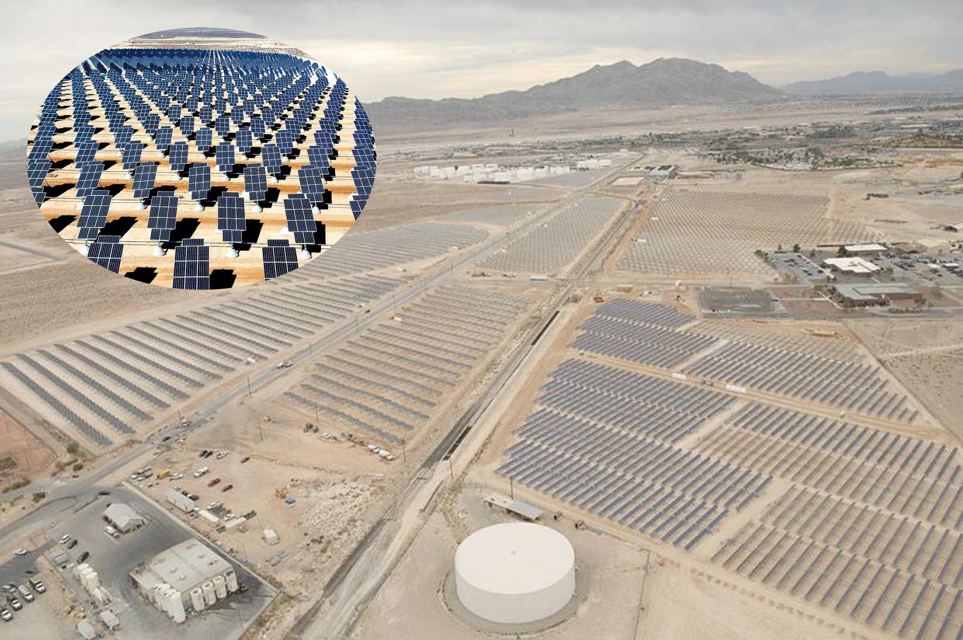
Nellis Solar Power Plant
